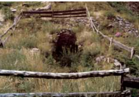
Aspecto del primer edificio termal ▼ antes de la intervención.
