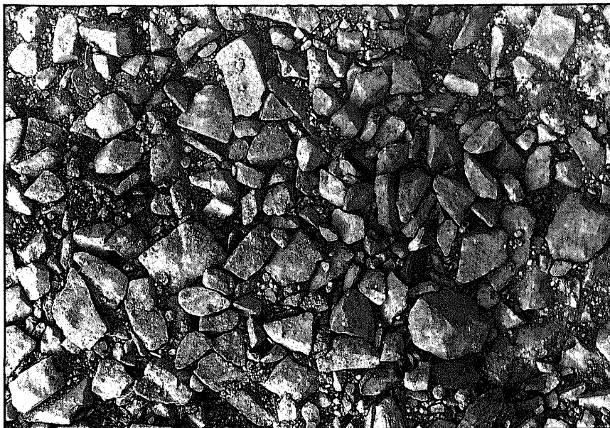
Fot.4 (Ch-96/29). Pavimento construcción C-2. Nivel intermedio de arena y grava menuda
