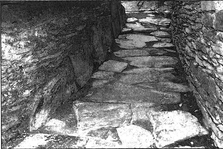
Fot.13. (Ch-101/10). Pasillo R-6
