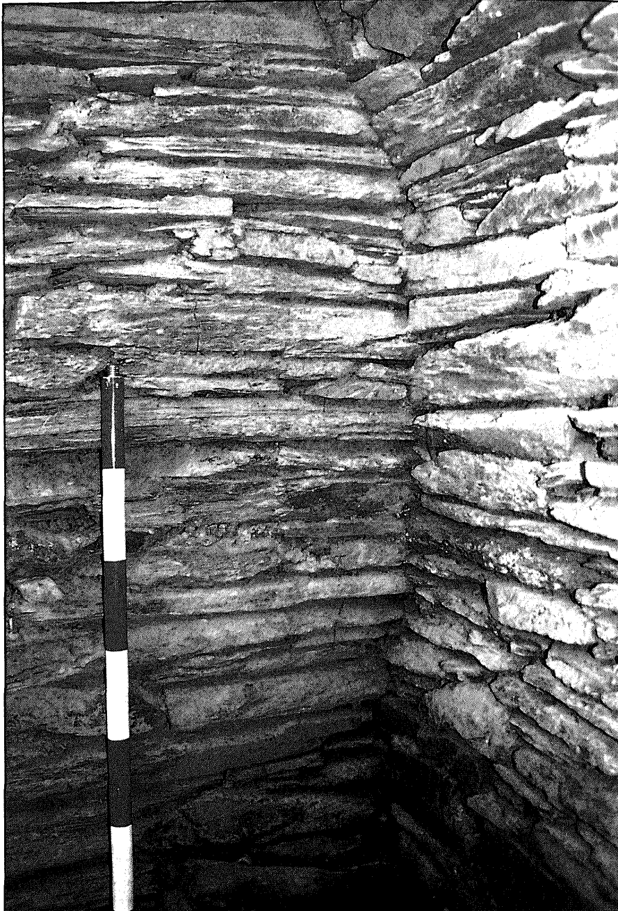
Fot.6 (Ch-100/34). Sauna castreña (Estancia C-3c). Arranque de la cubierta abovedada
