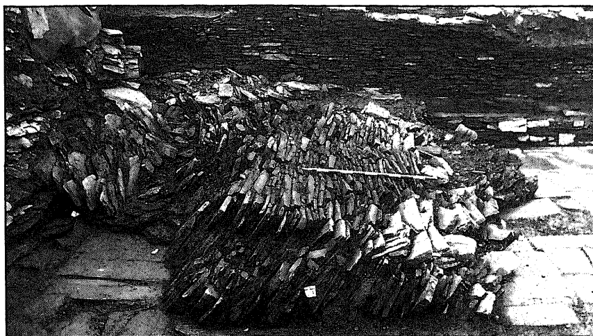
Fot.11 (Ch-28/11). P-III. El empuje de la roca provocó la ruina definitiva de este recinto, que nunca más volvería a ser reconstruido
