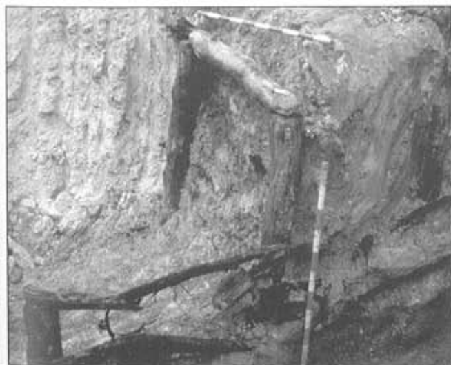
Lámina 3.—Entibado de una galería minera de época romana fabricada con madera de roble y castaño. El estudio dendrocronológico ha permitido situar la corta de los árboles en el año 56 d.C.
