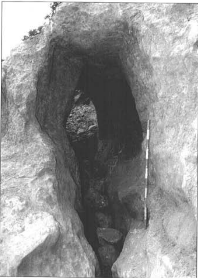
Lámina 2.-Galería dispuesta en materiales argilíferos profundos e inmediatos a depósitos mineralizados que discurre entre masas calizas interpuestas y ligeramente carstificadas que fueron acondicionadas para facilitar el tránsito y la continuidad de la prospección.
