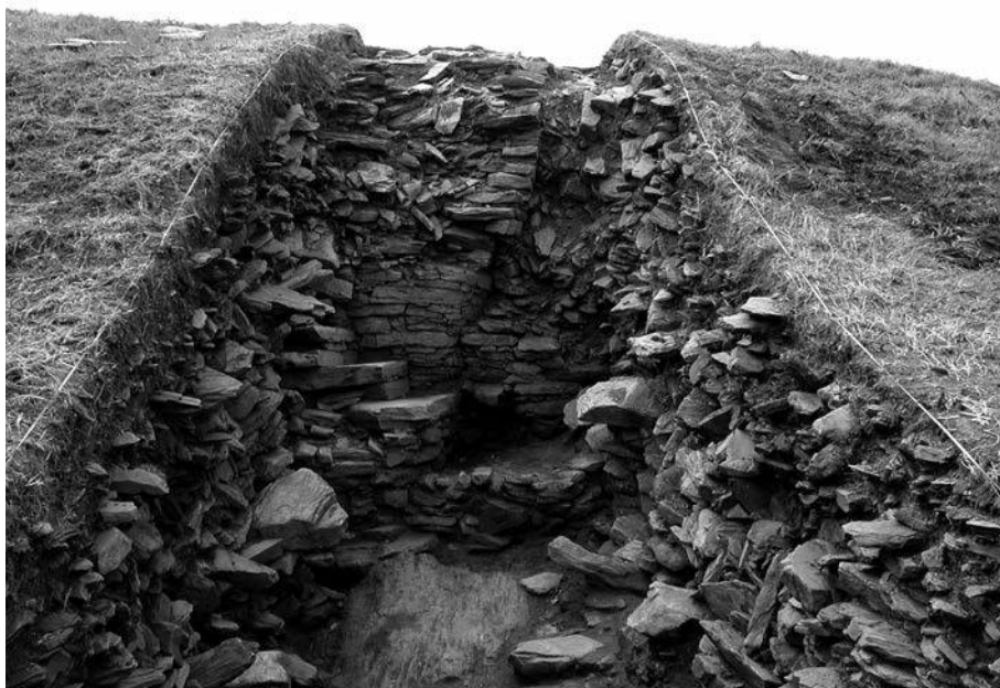
Figura 7. Muralla compartimentada que se extiende sobre la escarpa interior del foso 3 (Foto: A. Villa Valdés).
